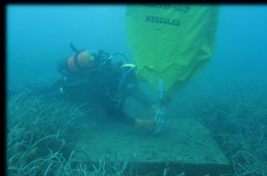
Figura 5. (izq.) Proceso de extracción de un bloque de hormigón utilizando un globo elevador.
