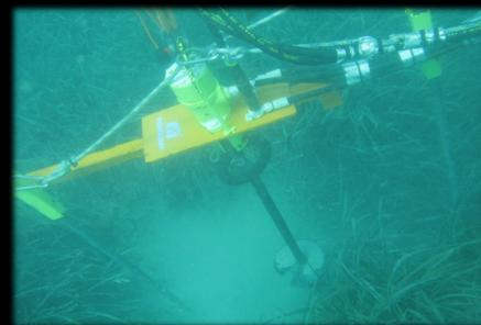
Figura 9. Colocación de un fondeo de bajo impacto Narval® con la ayuda de una máquina hidráulica ligera que facilita el proceso.
