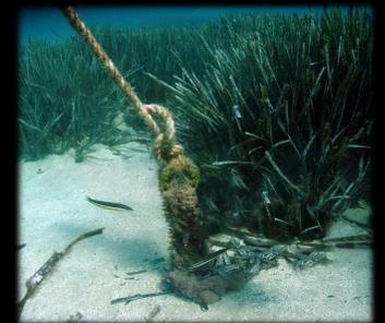
Figura 10. Fondeo de bajo impacto Narval® colocado junto a una mata de posidonia. Sólo queda visible la argolla para fijar el cabo o la cadena de la boya.
