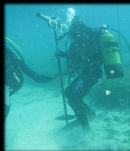
Figura 8. Colocación de un fondeo de bajo impacto tipo Narval®.
